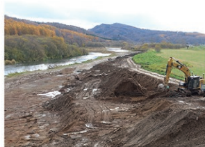
河道掘削状況（常呂川）
