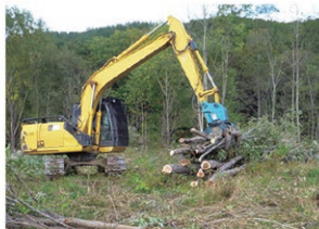
樹木伐採状況（渚滑川）
