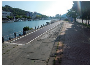
河川管理用道路（整備後）
