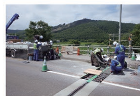
国道242号 橋梁老朽化対策
