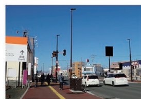
国道39号 北見駅西地区
