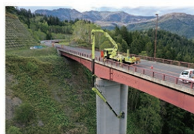
国道39号 橋梁点検
