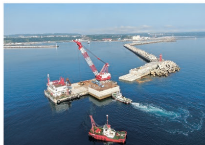
網走港新港地区 南防波堤
