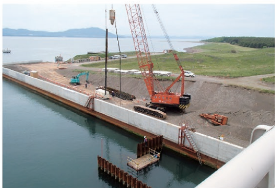
サロマ湖漁港(第2湖口工区)
