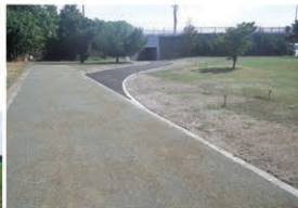
河川管理用道路(整備前後)
