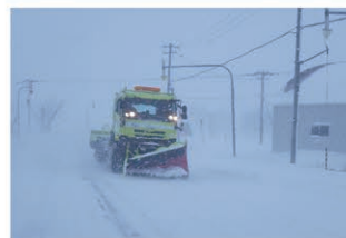
国道334号における除雪作業状況
