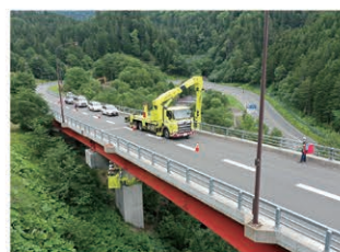
国道39号 橋梁点検
