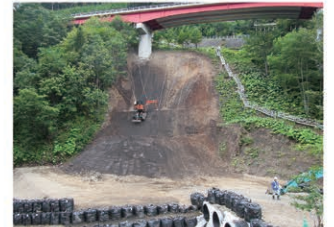
国道39号 赤岩法面对策工事
