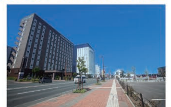
国道39号 北見駅西地区
