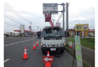
国道39号 附属物(道路標識)点検
