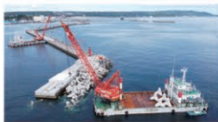
網走港新港地区 南防波堤
