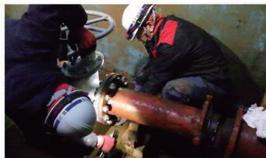
北見二期地区(井類の更新)
