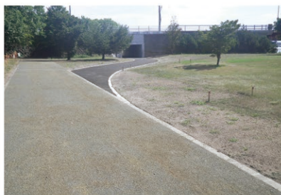
河川管理用道路整備
