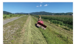
堤防除草状況(渚滑川)
