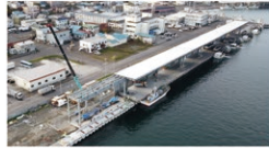
紋別港港町地区 水深4m西物揚場改良
