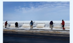
防護柵の堆雪除雪作業
