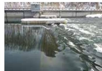
網走川大曲堰鋼製起伏ゲート起立中
