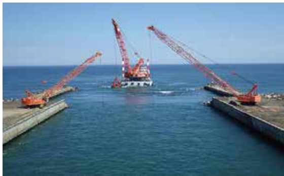
サロマ湖漁港(第2湖口工区)水深4.5m 航路浚渫
