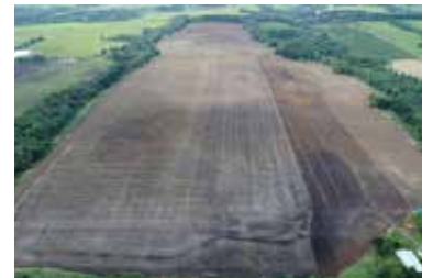
雄武丘陵地区北幌内13工区 区画整理
