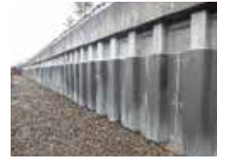
網走川特殊堤の補修完了状況
