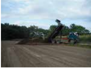
農地復旧状況
