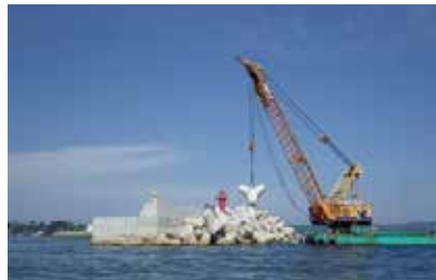
網走港新港地区 南防波堤
