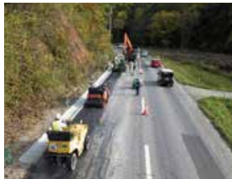
国道333号路肩改良（交通安全対策）
