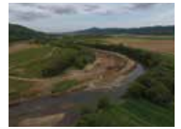
常呂川の河道掘削状況
