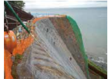
国道334号真鯉道路（防災対策）
