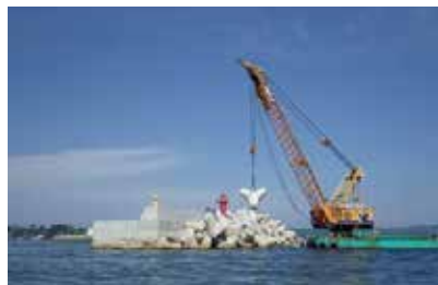
網走港新港地区 南防波堤
