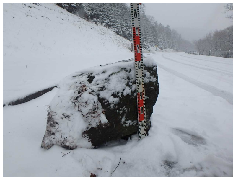
落石の状況②(近景)
