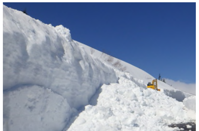
道路上に堆積した雪のロータリ除雪車等を用いた除雪作業
