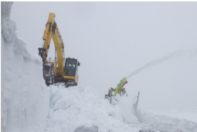
道路上に堆積した雪のロータリ除雪車等を用いた除雪作業
