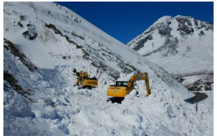
除雪作業前の雪割作業と雪崩防止のための法面除雪
