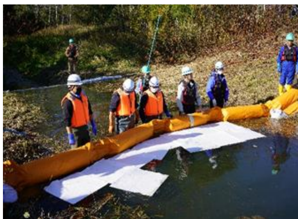
現地対策訓練（オイルフェンス設置）
