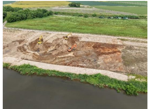
河道掘削（常呂川）
