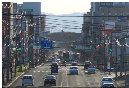
電柱倒壊による道路閉塞のリスクがある 市街地等の緊急輸送道路（北見市 国道39号）
