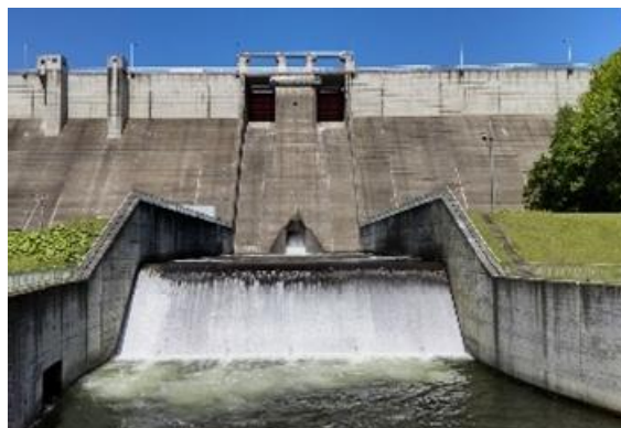
防災操作（鹿ノ子ダム）
