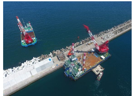
新港地区 南防波堤改良
