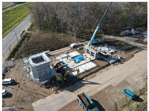
排水施設の整備（常呂川下流地区）
