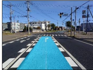
カラー舗装による走行位置の明確化（網走市）
