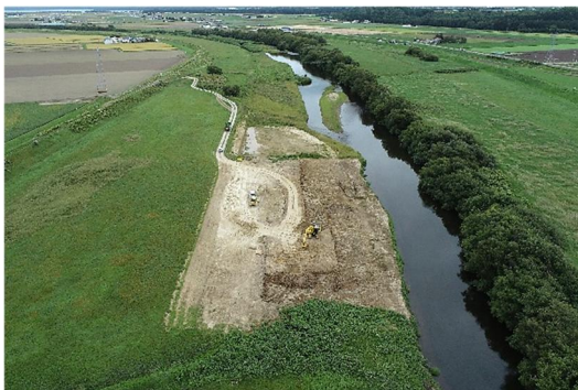
河道掘削（網走川）
