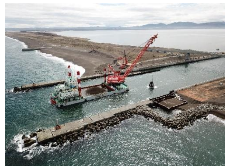
網走管内地区 サロマ湖漁港(第2湖口) 水深4.5m航路(補修)
