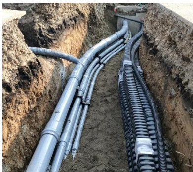
角型多条電線管施工状況 （北見市 国道39号）
