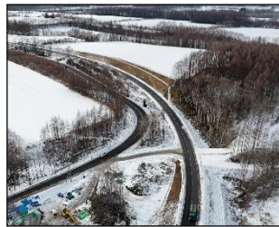
急カーブ区間の解消（大空町）
