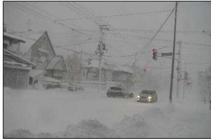
暴風雪・着水による電線の破断（網走市 国道244号）
