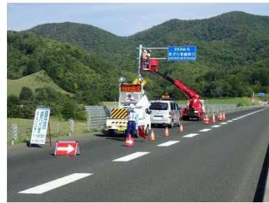
附属物（道路標識）点検状況 (北見市 国道39号)
