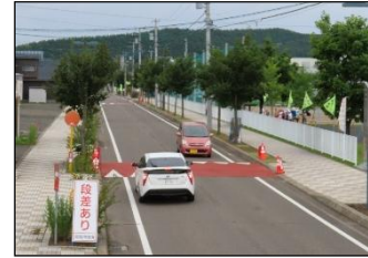
可搬式ハンブ設置状況（北見市）
