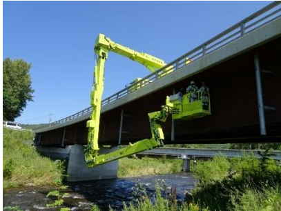
橋梁点検状況 (北見市 国道242号)
