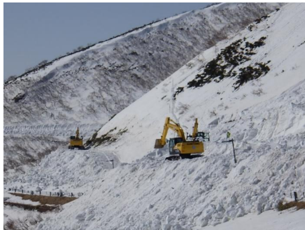
油圧ショベルによる斜面除雪
