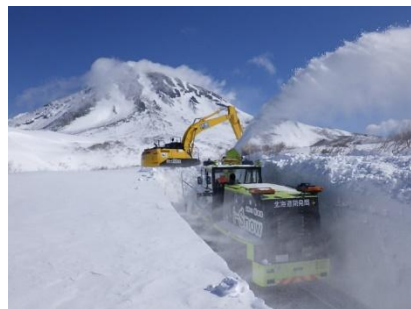
ロータリ除雪車による作業状況
