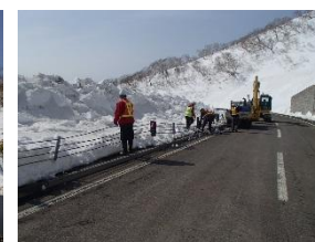
標識、ガードケーブル等、道路付属物の復旧状況
