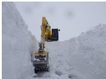
油圧ショベルによる作業状況
