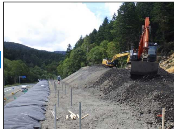
復旧工事の状況
