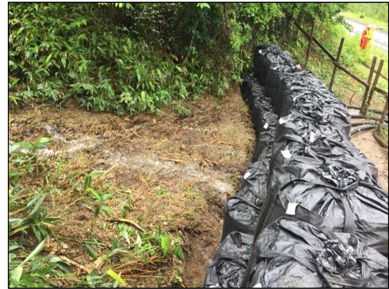
旭川・紋別自動車道 応急復旧完了
