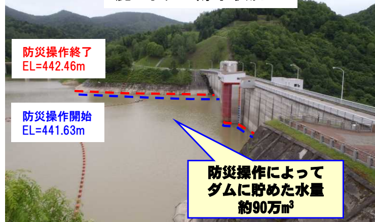
鹿ノ子ダム貯水状況
