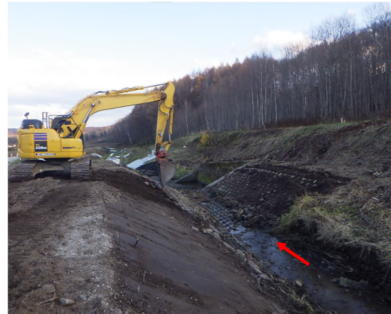
ポンニコロ川 施工中 (R4.11)
