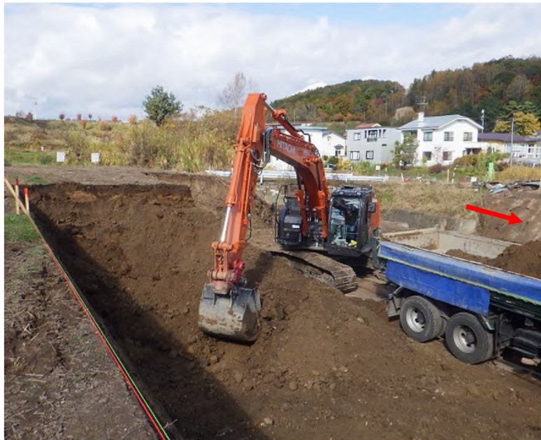
小石川 施工中 (R4.11)
