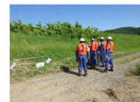
巡視による堤防漏水の発見
