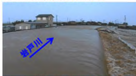
岩戸川の氾濫状況
