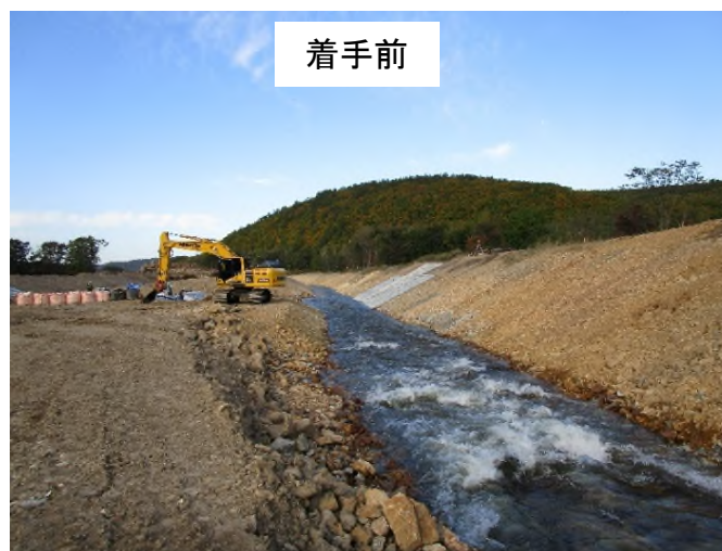
河道掘削の実施(生田原川)
