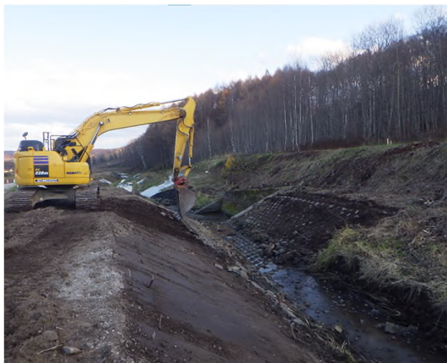
河道掘削の実施(ポンニコロ川)
