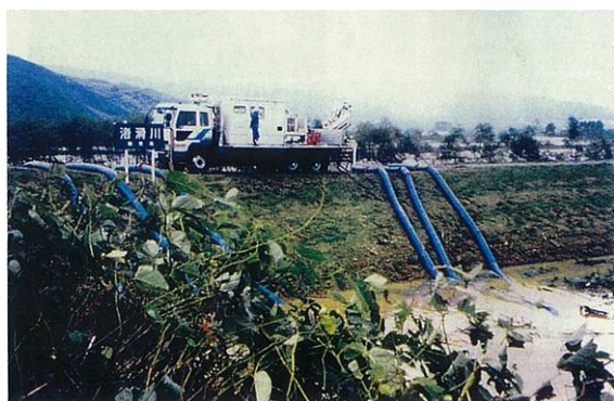
平成 10 年(1998 年)9 月洪水の状況 (ウツツ地区の内水排除状況)
