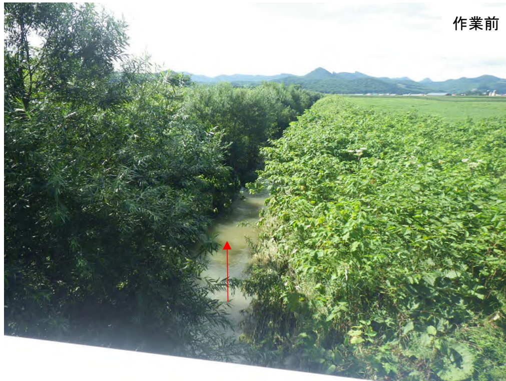
河道掘削（鴻輝川）
