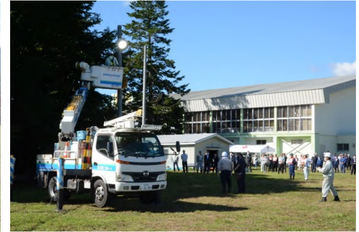
照明の設置訓練
