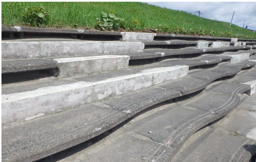
○撮影場所 : 美幌町 網走川 大正橋上流左岸 KP=31.3付近 ○写真説明 : 階段護岸の補修箇所を確認
