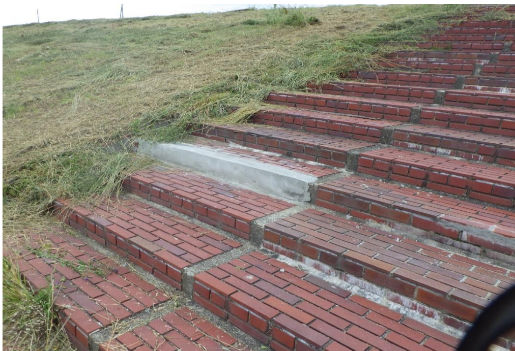
○撮影場所：北見市 常呂川 左岸 KP=47.0付近 ○写真説明：階段護岸の補修箇所を確認
