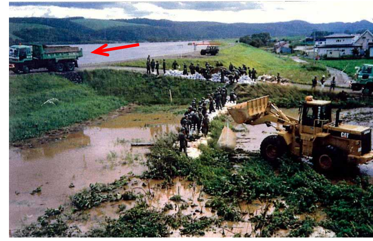
北見市 常呂地区基盤漏水への対応
