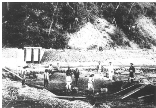
昭和初期の治水工事
