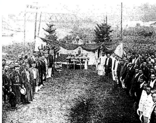
常呂川治水工事起工式 (大正 10 年 8 月 1 日) 常呂町史より
