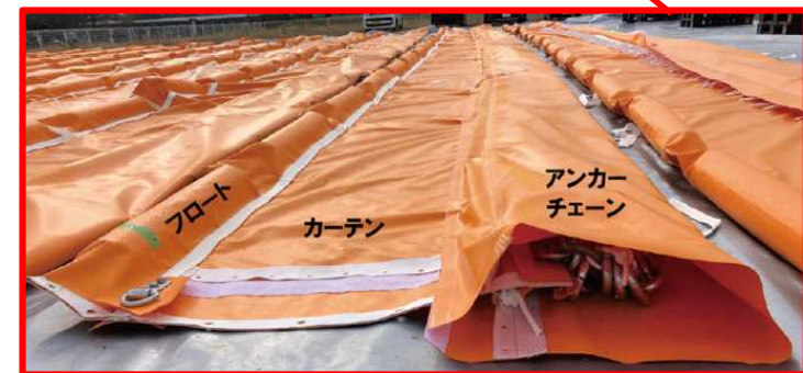
図-フェンスの設置状況
