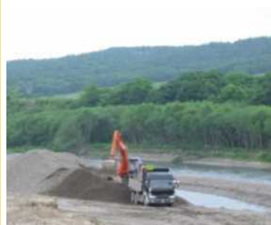
河道掘削した土砂を、
