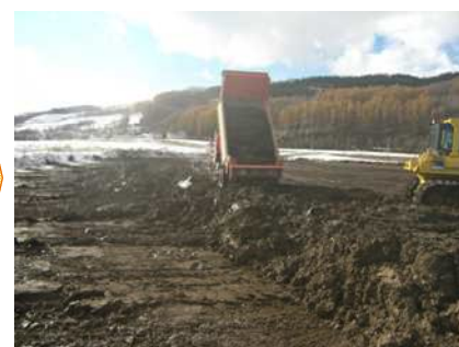
土砂が流出した農地へ運搬し、
