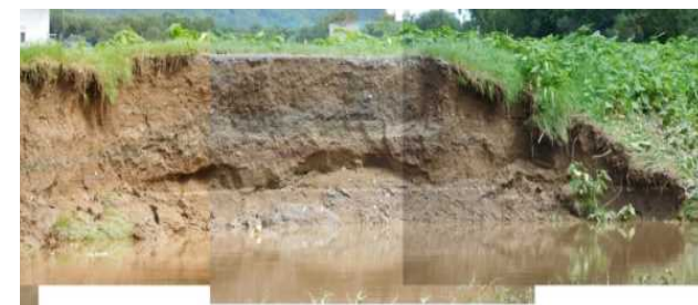
堤体の土質 (決壊部の直下流)
