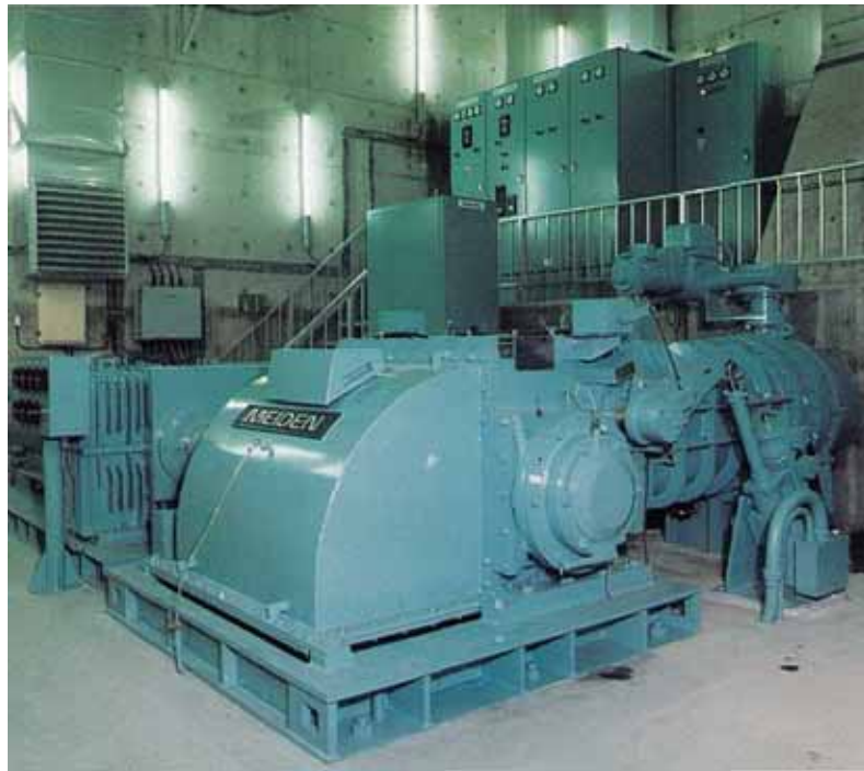
鹿ノ子ダム管理用水力発電設備
