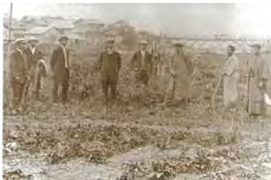
常呂川氾濫の被害状況の視察 (大正8年)
