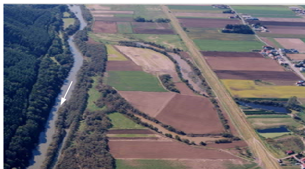
旧川跡地に築造された堤防
