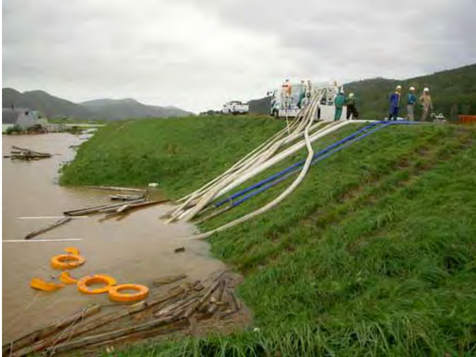
ポンプ車による内水排除の状況
