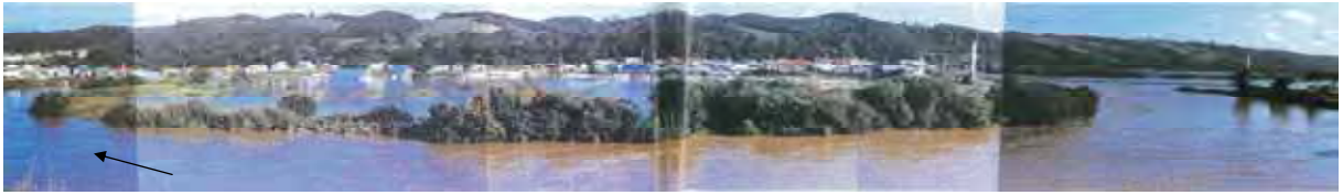
昭和 50 年 8 月洪水時状況 (北見市 河口地区の氾濫)
