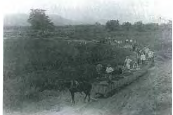
常呂川治水工事風景 (大正10年頃)
