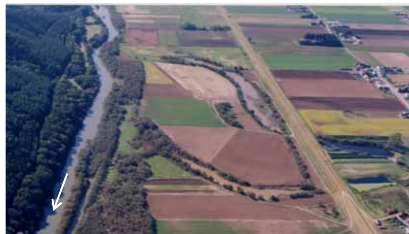
旧川跡地に築造された堤防
