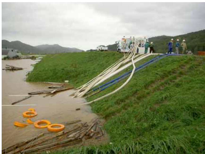
ポンプ車による内水排除の状況
