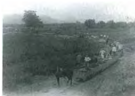
常呂川治水工事風景 (大正10年頃)
