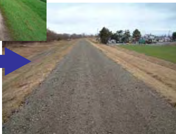
堤防天端の維持管理
