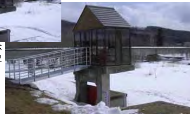
樋門管理橋の補修及び安全対策
