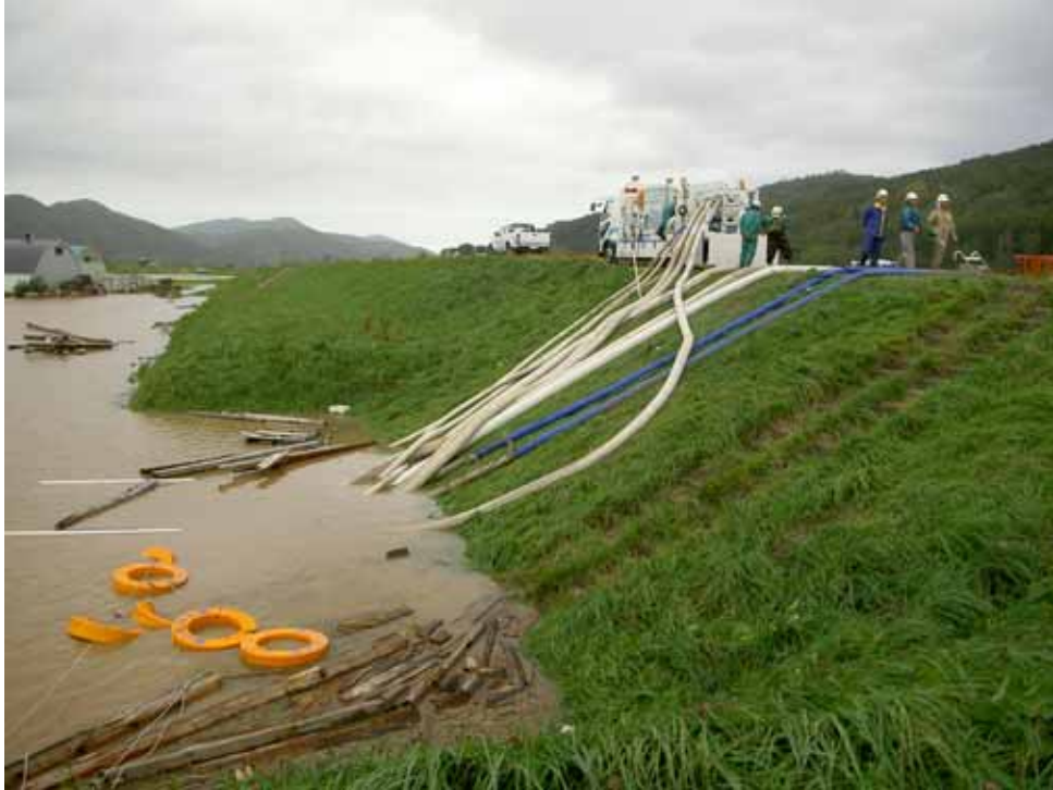
ポンプ車による内水排除の状況
