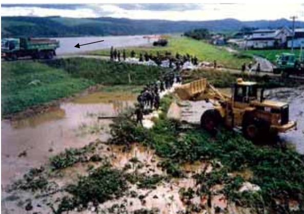
平成 4 年 9 月洪水の状況 (北見市 常呂地区基盤漏水への対応)
