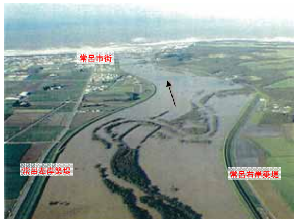
平成 10 年 9 月洪水の流下状況 (北見市)
