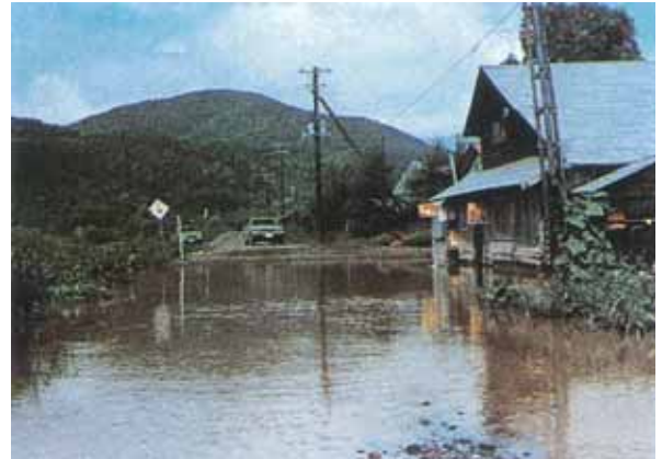
昭和 50 年 8 月洪水の状況 (北見市 福山地区の家屋浸水)
