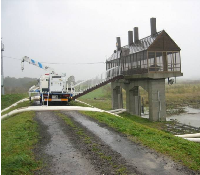
ポンプ車による内水排除の状況
