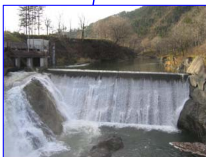
濁川発電所取水堰 (下流より望む)
