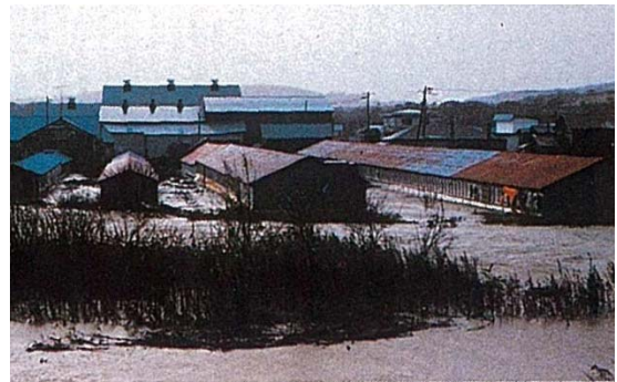
昭和 54 年 10 月洪水の状況 (渚滑右岸市街のはん濫)
