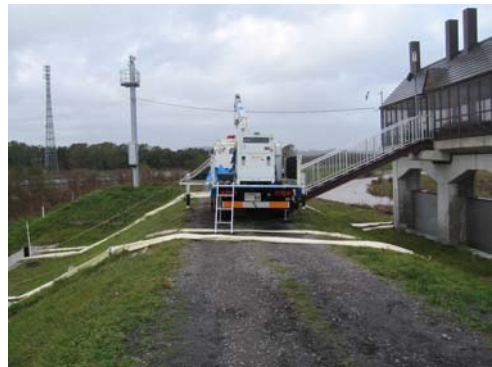
平成 18 年 10 月洪水の状況 (渚滑右岸樋門排水作業状況)
