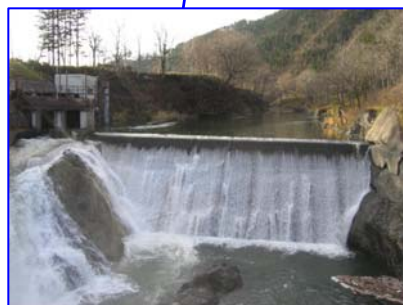
濁川発電所取水堰（下流より望む）
