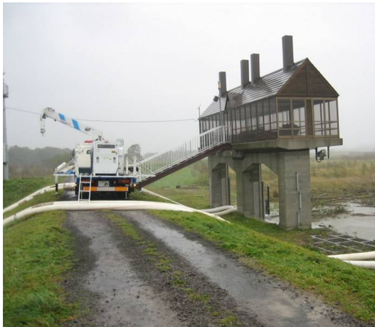
ポンプ車による内水排除の状況
