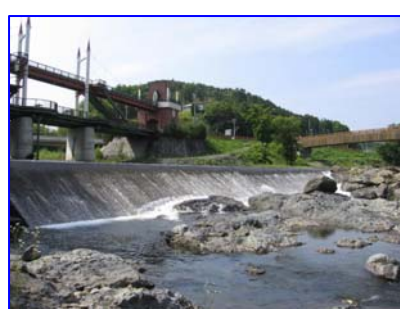
滝の上発電所取水堰（下流より望む）
