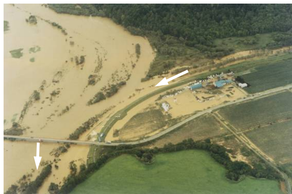
平成 10 年 9 月洪水の状況 (ウツツ川合流点付近のはん濫状況)
