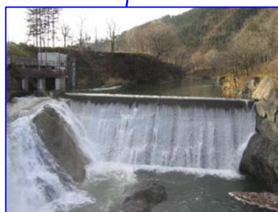
濁川発電所取水堰（下流より望む）
