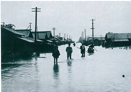
大正 11 年 8 月洪水時状況 (渚滑右岸市街のはん濫)
