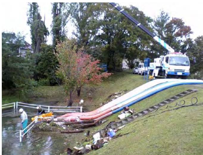
ポンプ車による内水排除の状況
