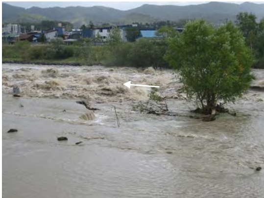
出水中の河道状況
