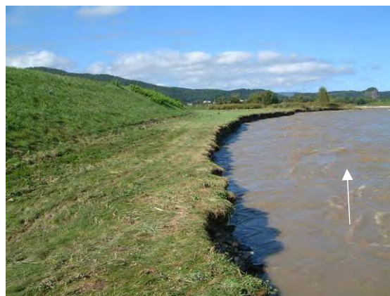
平成 13 年 9 月洪水の状況 のがみ （野上左岸高水敷の被災状況）
