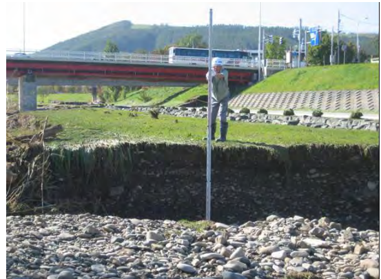
高水敷の洗掘被災
