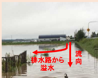
排水路からの溢水による湛水被害
