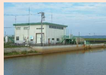
排水能力の不足(豊住排水機場)
