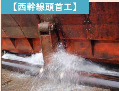
ゴムの劣化によるゲートの漏水状況
