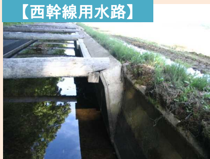
側壁の傾倒状況 （切梁により応急対応）
