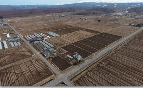
区画整理工事 整備前 (国営緊急農地再編整備事業 大雪東川第一地区)
