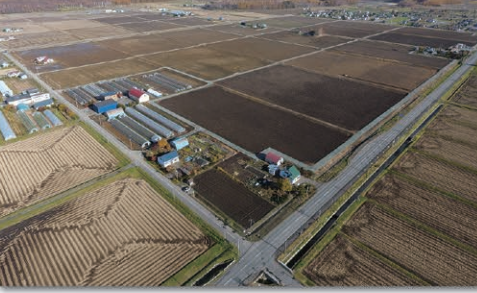
区画整理工事 整備後 (国営緊急農地再編整備事業 大雪東川第一地区)
