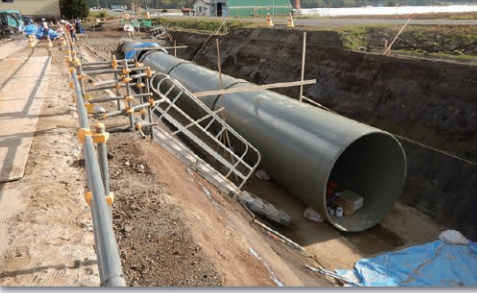
用水路工事写真 (国営施設応急対策事業 鳥沼宇文地区)
