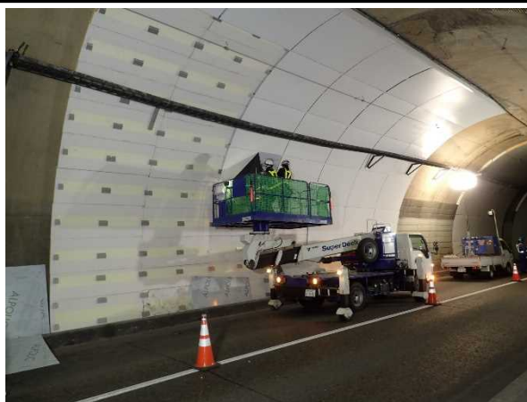
【道路トンネル補修】
