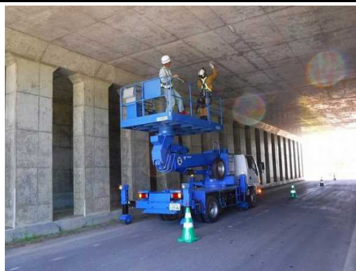
【大型カルバート点検】
