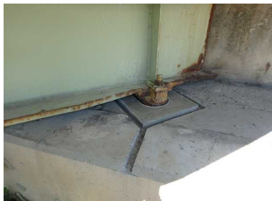
【橋梁補修後（支承）】
