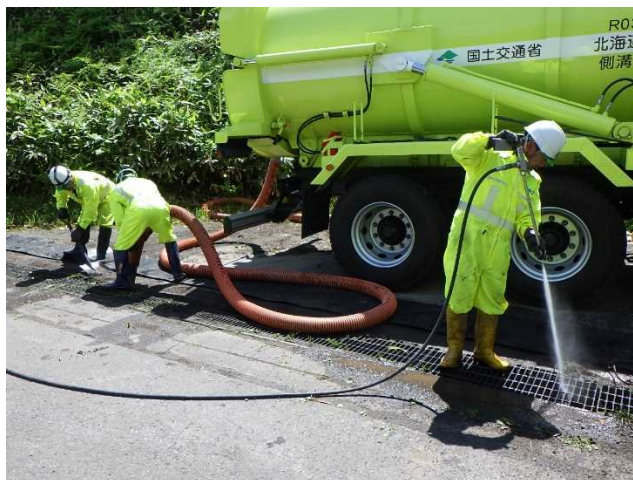
【排水構造物清掃】
