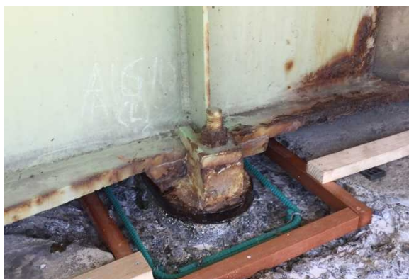
【橋梁補修前（支承）】
