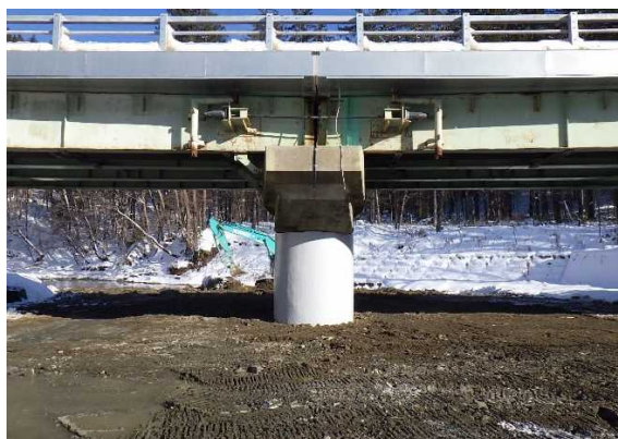
【耐震補強（下部工補強）】
