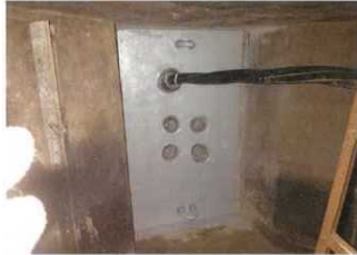
補修後（壁面補修）
