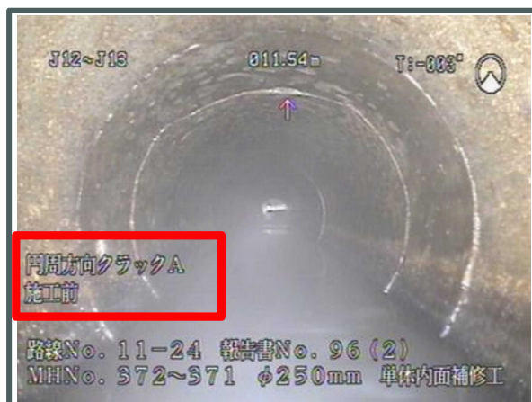
TVカメラによる管内の詳細調査
