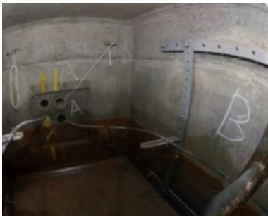
マンホール内写真
