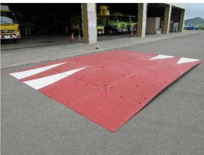
旭川開発建設部では仮設用として設置・撤去が可能な据え置き型のゴム製の可搬式ハンプの貸し出しを行っています。
