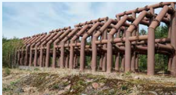
富良野川第2号透過型堰堤
