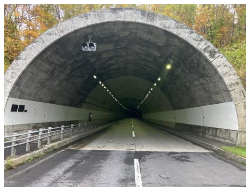
道路照明灯のLED化(国道12号 旭川市 旭川トンネル)
