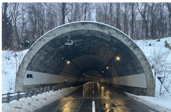
道路照明灯のLED化(国道12号 旭川市 旭川トンネル)
