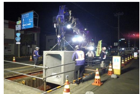
電線共同溝の整備（国道38号 富良野市）
