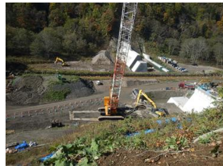
白川第1号砂防堰堤 整備状況 （上川町）
