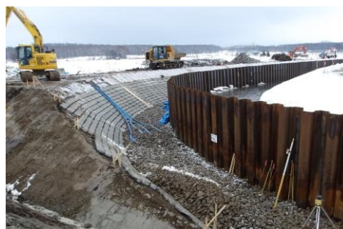
排水路の改修
