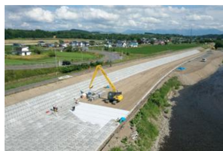
辺別川 護岸整備状況(旭川市)
