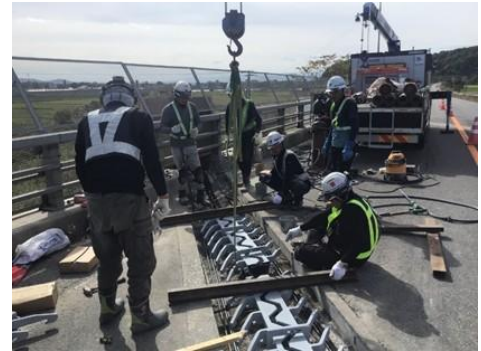
橋梁の老朽化対策（国道40号 比布町）
