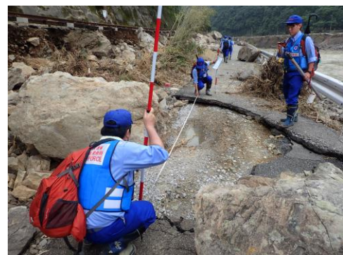
TEC-FORCE の派遣による自治体支援 （令和2年7月 熊本県）
