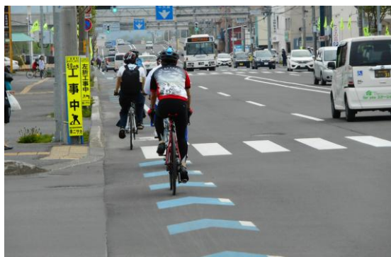
自転車の通行位置を示す矢羽根型路面標示の設置 (国道 237 号 旭川市)
