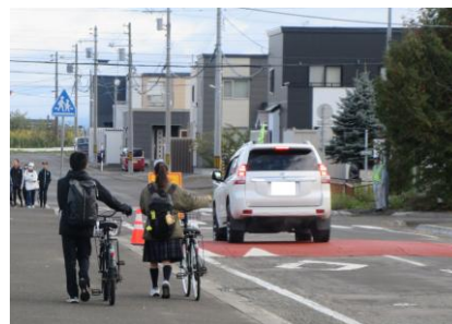
可搬式ハンブ設置状況(富良野市)
