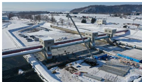
近文頭首工の改修、耐震対策
