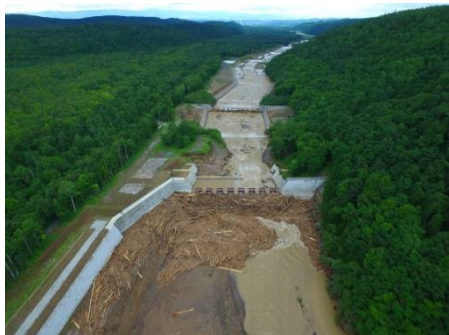
砂防施設による流木捕捉状況
