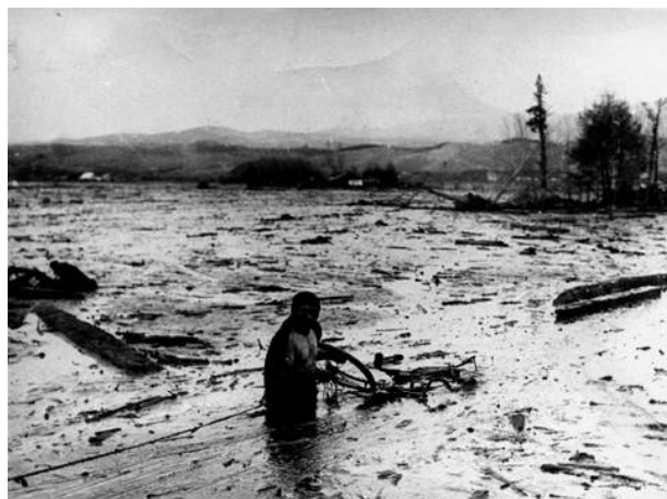
大正泥流による市街地被害
