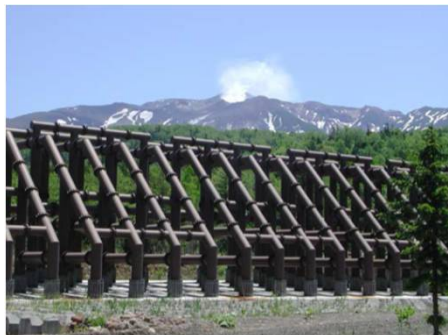
富良野川の砂防施設整備状況
