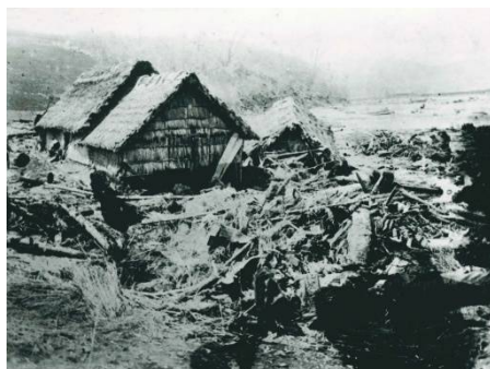
大正泥流による住宅被害
