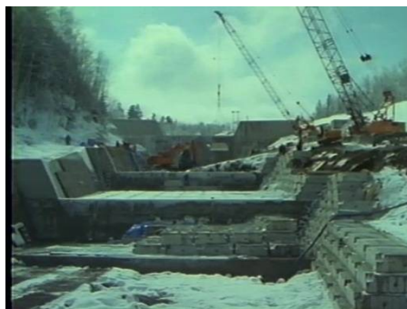
尻無沢川の流路工整備状況
