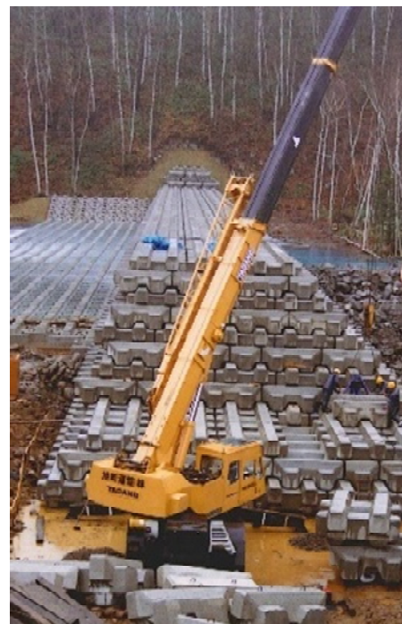
1988年噴火を契機に実施した ブロック堰堤の整備
